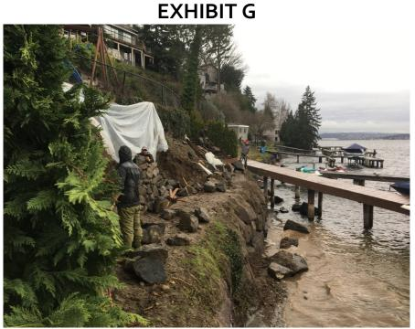
02/02/2018 – EXCAVATION AND ROCKERY CONSTUCTION IN SHORELINE SETBACK DURING BANNED SEASON WITH NO EROSION CONTROL,
